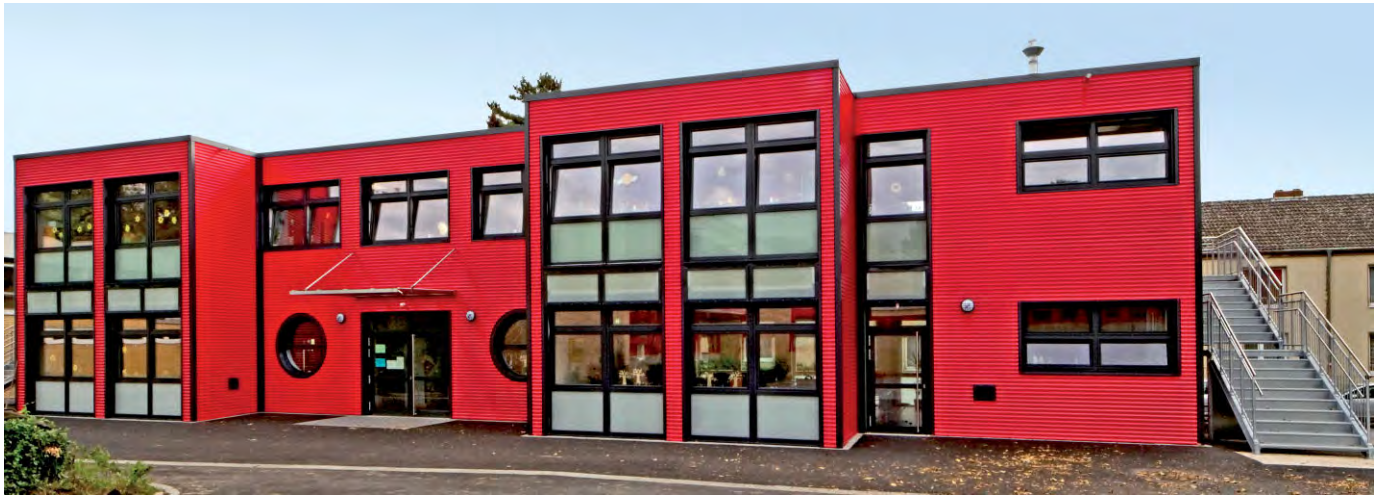
Bild 1. Edith-Stein-Schule in Frechen: Erweiterung in Modulbauweise
