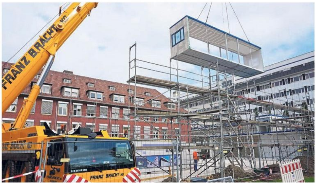
Modul am Kran: Hinter dem Haupthaus des Evangelischen Krankenhauses entsteht derzeit die modulare Entbindungsstation. Bis Freitag werden alle 21 Module, die dafür benötigt werden, angeliefert und aufgebaut. FOTOS: CEGELSKI
