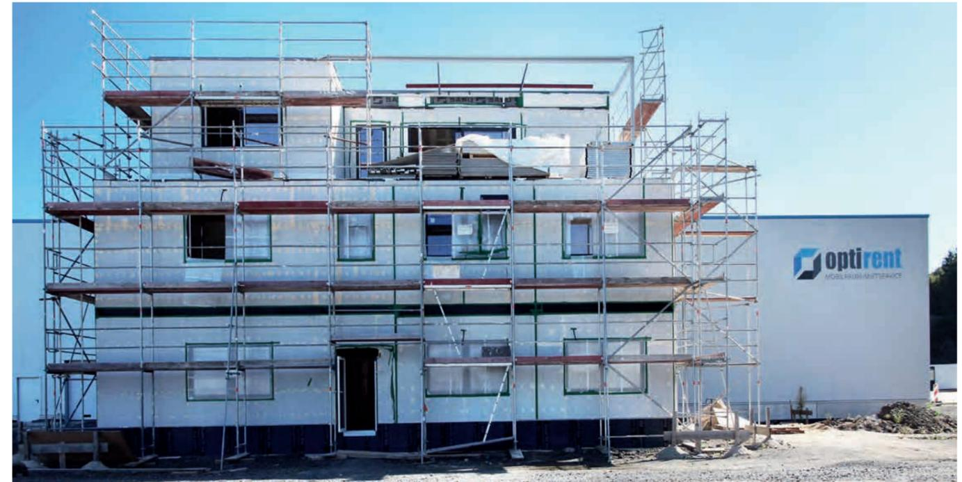
Noch während die Module miteinander verbunden wurden, wurde das Gebäude eingerüstet, hier speziell für den Einbau der Fenster vor Ort, die späteren Fassadenarbeiten sowie die Dachabdichtung und Montage der Photovoltaik-Anlage.
