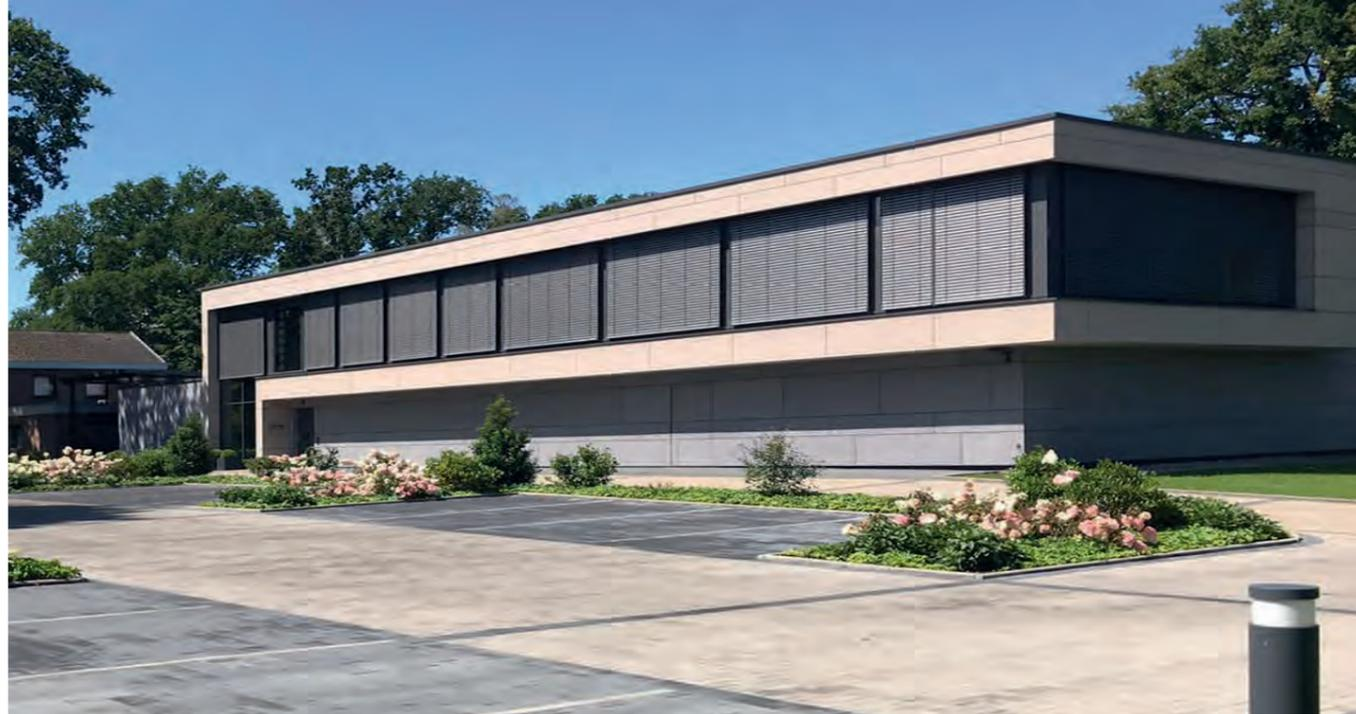
Für den außenliegenden Sonnenschutz als Wärme-, Licht- und Blendschutz wurden randgebördelte Lamellen mit hoher Stabilität und geringer Geräuschkentwicklung der Antriebsmotoren gewählt.
