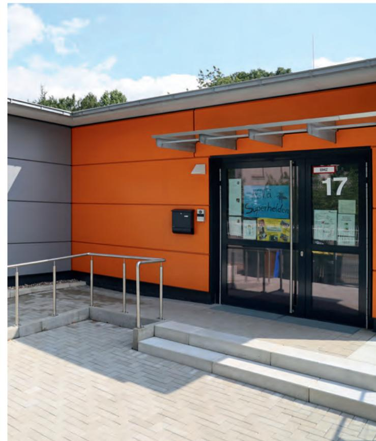
Im Bereich des Gebäuderücksprungs über dem Hauseingang wird ein transparentes Glasvordach von ca. 4 Meter Breite und 1,20 Meter Auskragung stützenfrei mit einseitigem Fallrohr an die allgemeine Dachentwässerung angeschlossen.
